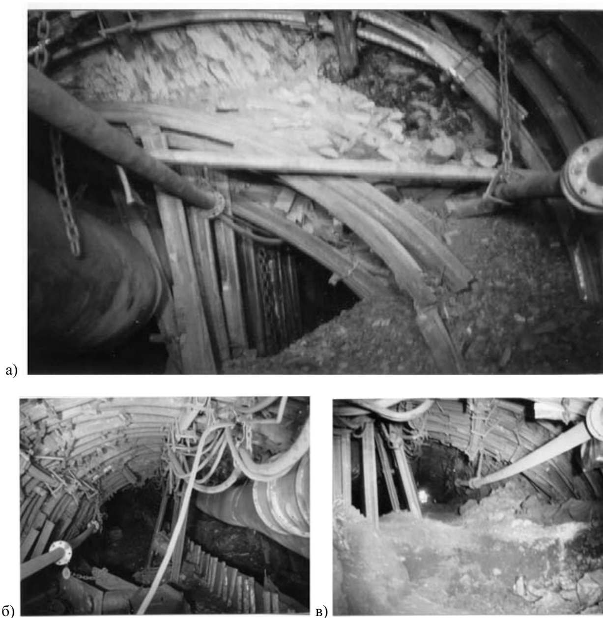
Рис. 6 – Состояние конвейерного штрека без крепи усиления (а) при перекреплении на расстоянии 220 м за забоем 2-й западной лавы; и с продольно-жесткой крепью усиления на расстоянии 120 м (б) и при подрывке почвы в 230 м за очистным забоем (в)
